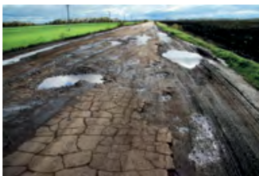
Дорога місцевого значення
